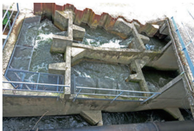
Passe à poissons – Usine hydroélectrique de Decize (58)
