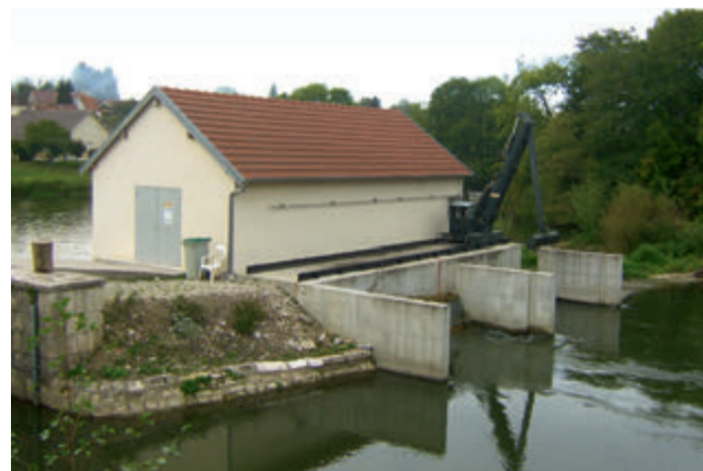
Entrée d'eau et dégrilleur automatique - Centrale de Port-sur-Saône (70)
