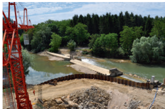
Travaux d'optimisation et de rénovation - Moulin de la Tête Noire à Briennon-sur-Armançon (89)
