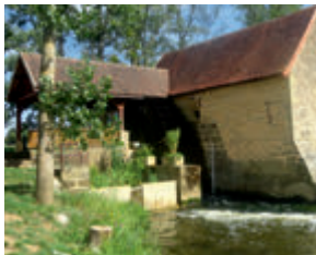
Roue à aubes de 30 kW - Moulin de Lugny-lès-Charolles (71)
