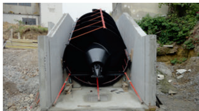
Chantier de pose d'une vis hydrodynamique - Moulin de Champdôtre (21)
