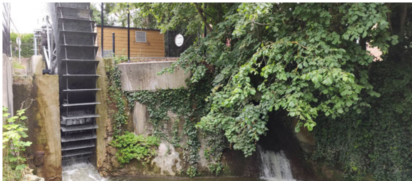
Dans le Nord, Goeulzin a été parmi les premières communes, à valoriser en autoconsommation collective l'électricité de sa centrale, pour alimenter ses propres bâtiments.
